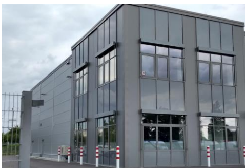
Neubau am Promenadenweg in Oppum-Linn (Quelle: IRI)
