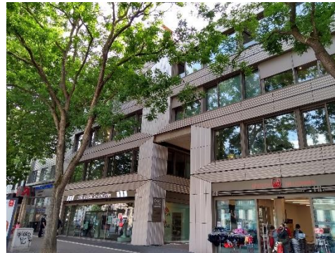
Neubau der Ostwallpassage (Quelle: IRI)
